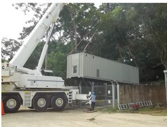
Imagem 3 : descarregando o container
